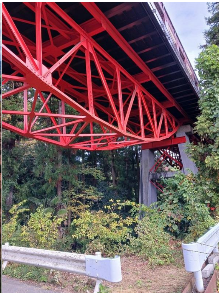
道路側から見た奥多摩橋
